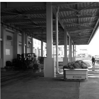
完成し稼動した水産荷捌施設
