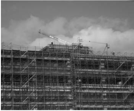
工事の進む浦河赤十字病院
