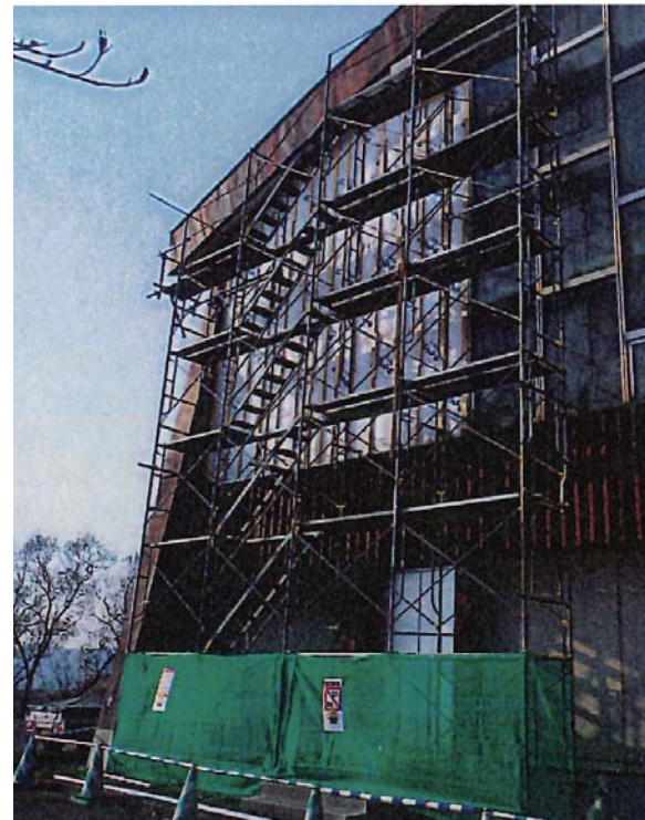
▲ファミリースポーツセンターの壁補修
