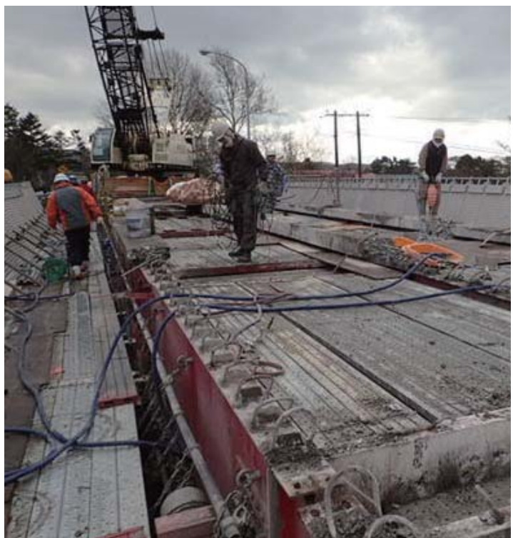
▲工事進む姉茶橋
