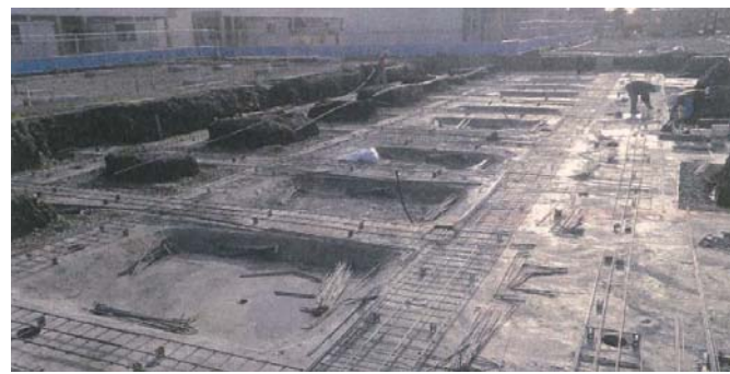
▲基礎工事が進む川沿団地
