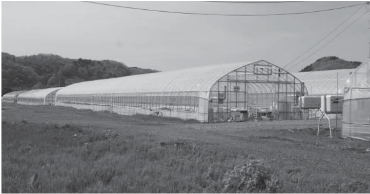
グリーンサポートのハウス団地 (富里 20 棟)
