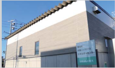
木質バイオマス エネルギーセンター
